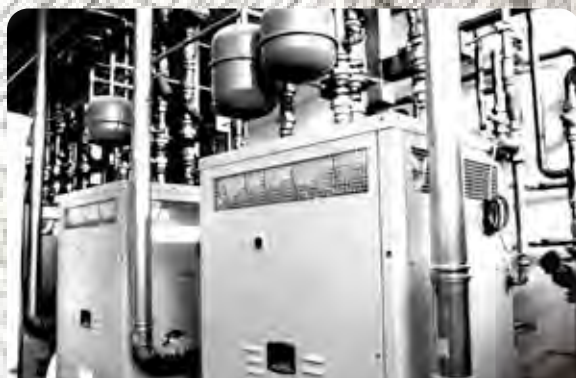
CENTRALE TERMICA E FRIGO
